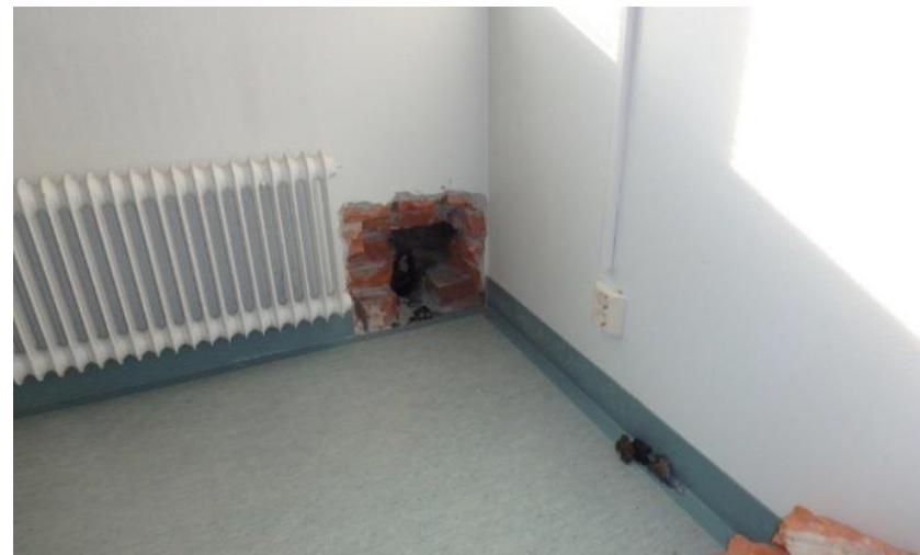
Kuntotutkimuksen tyypillinen rakenneavaus ulkoseinän alaosaan, jolla tutkittiin tuulettumattoman tiili-villa-tiili-rakenteen eristeen kuntoa.
