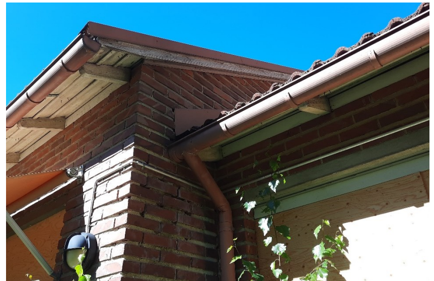
Kalevan lastentalon räystäsrakenteita. Kuva Tampereen kaupunki 2022.
