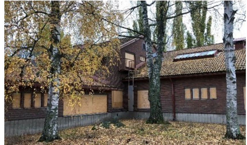
Seimen pohjoislaapeella on nähtävissä todennäköisesti vuonna 1990 toteutettu lapeikkuna. Kuva Tampereen kaupunki 2022.
